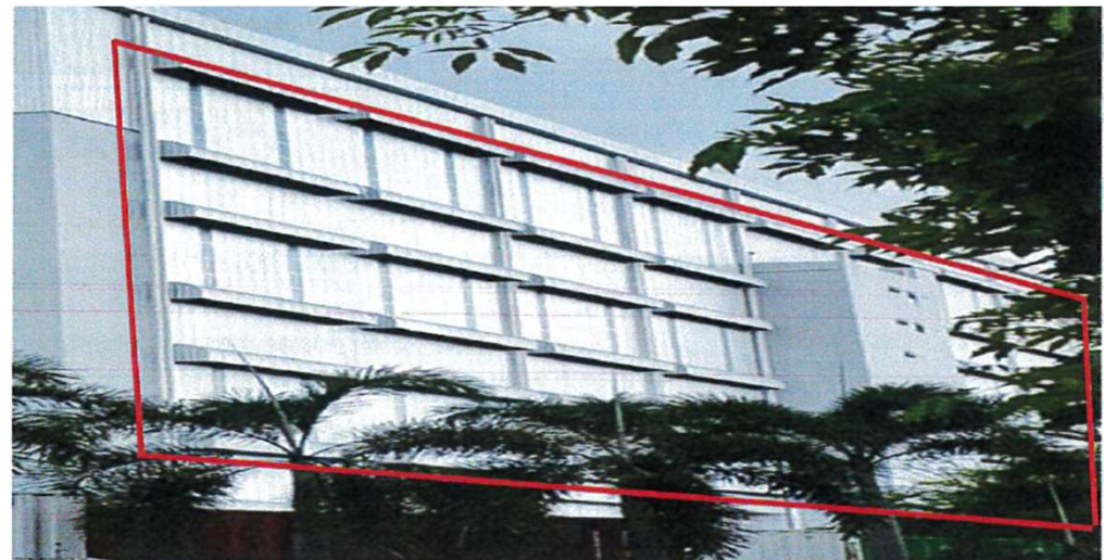
Gambaran kanopi yang dilihat mengepung bukaan sistem pengurusan asap
